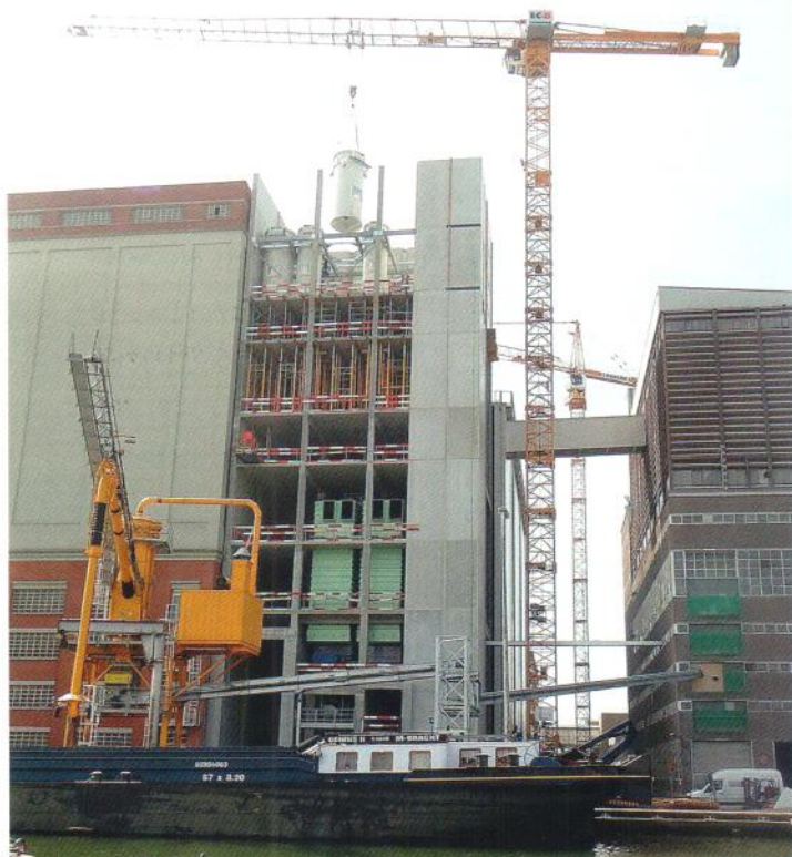
Montage van filters voor nieuwe tarweopslag
